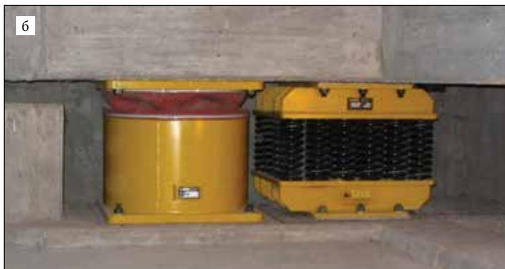
Рисунок 3 – Система BCS (Base Control System) в монтажном (а) и рабочем (б) положении. Пружинные блоки для вибро- или сейсмоизоляции. Фирма GERB. Демпферы (ВД). (Российская разработка ООО «ЦВС», ТУ 4192-001-20503039-01)
